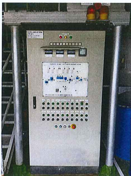
Hình 4.1. Tủ điều khiển trung tâm hệ thống xử lý nước thải
