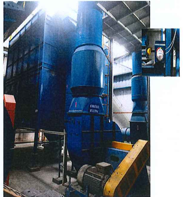
Hình 4.6. Gắn đồng hồ áp suất tại HTXL bụi
