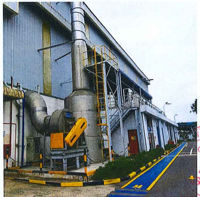
Hình 4.8. Xây gờ xung quanh HTXL khí thải, đường ống dẫn nước thải về HTXL nước thải
